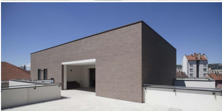
Résidence Le Chorus à Lyon - Crédits photo : Studio Gardoni Architectes
